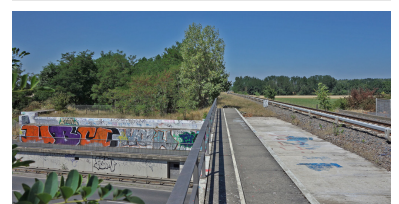
Anfang der 1990er Jahre baute die Reichsbahn bereits weitsichtig die S-Bahn-Brücke über die L76 für zwei Gleise und die Widerlager für vier Gleise.
