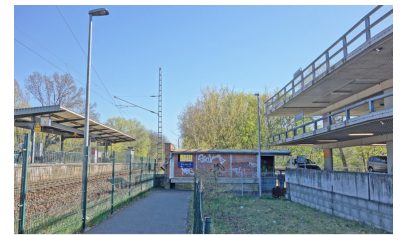
Bahnhof Blankenfelde, links der alte Regionalbahnsteig, rechts das Parkhaus. Der neue Bahnsteig und das S-Bahn-Gleis rücken so dicht an das Parkhaus heran, dass ein zweites S-Bahn-Gleis mit Seitenbahnsteig keinen Platz mehr findet. Die bestehenden Bahnsteige werden komplett zurückgebaut und an neuer Stelle neu errichtet. (Foto: André Casper)
