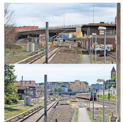
Der andere Übeltäter, die »Westendbrücke« am S-Bahnhof Westend, oben schon ohne Autoverkehr und mit gesperrtem S-Bahn-Verkehr unter der Brücke, unten nach dem Abriss der Brücke und mit abgerissenem Stellwerk, sowie mit wieder aufgenommenem S-Bahn-Verkehr.
